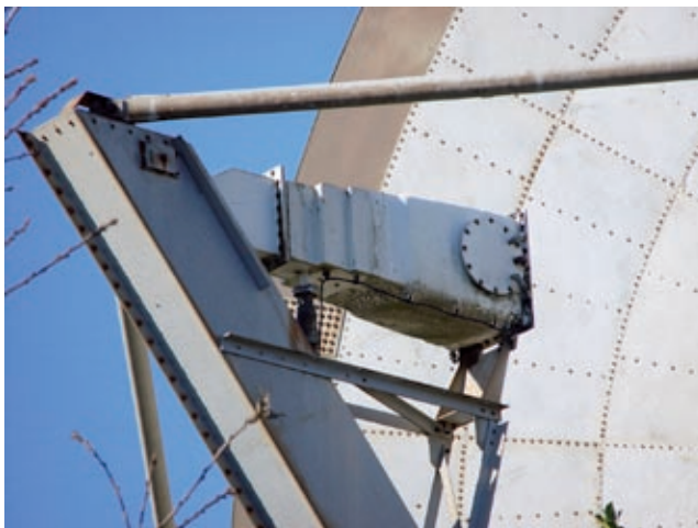
Uno degli illuminatori della Tolfa: si noti che, a differenza di quello del Giogo, la discesa della ricezione si collega al dipolo nella parte inferiore del feedhorn, indice di polarizzazione verticale. Infatti l'inserzione della guida nell'illuminatore è ruotata di 90 gradi rispetto a quella del Giogo (polarizzazione orizzontale). La piastra imbullonata visibile sul lato è uno dei due riscaldatori di cui erano dotati i feedhorn per evitare la formazione del ghiaccio: l'altro è sotto e si accendevano automaticamente ad iniziare da +5 gradi (il primo) e a 0 gradi il secondo.
