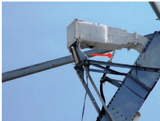
Uno degli illuminatori dei paraboloidi del Giogo: la freccia rossa indica la discesa della ricezione collegata al dipolo logaritmico con ingresso laterale, indice di polarizzazione orizzontale: infatti la trasmissione (vedi guida inserimento guida d'onda nel feedhorn) del Giogo avveniva in verticale, polarizzazione ottenuta ruotando la guida tramite un twist nel tratto annesso al braccio di supporto della culla dell'illuminatore stesso
