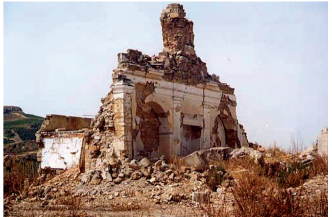
Chiesa distrutta dal terremoto
